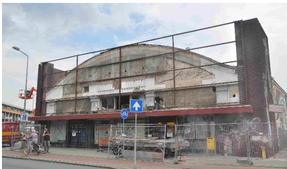
Ontmantelde voorgevel waar elementen van de voorgevel uit 1912 tevoorschijn zijn gekomen
