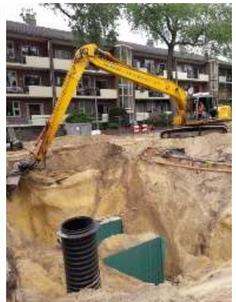
Aanleg infiltratievoorziening Laan 40-45
